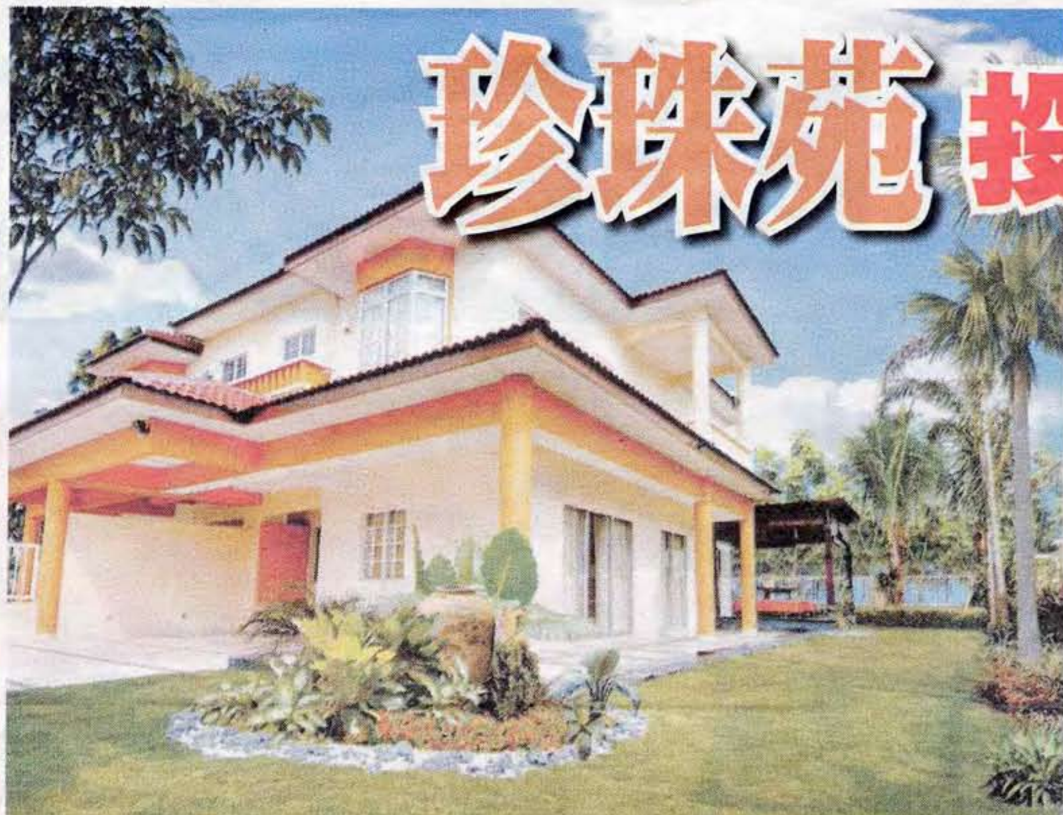
珍珠苑湖景楼房实景图。
